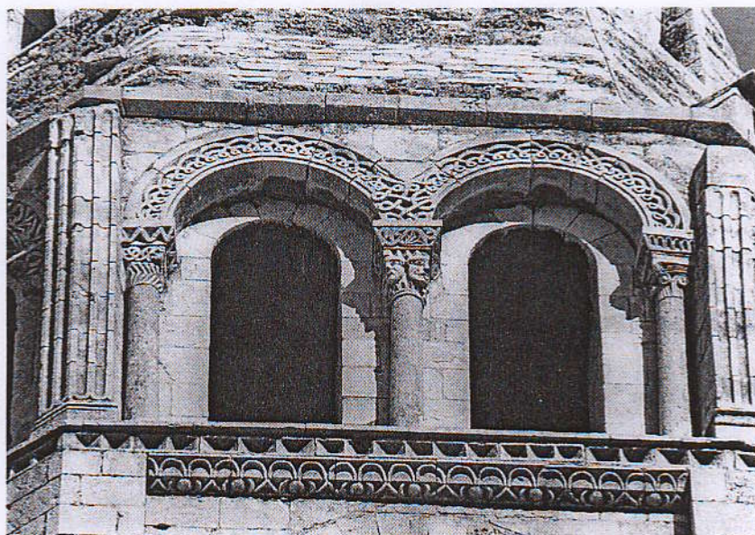
FIG. 13. — ÉTAGE SUPÉRIEUR DU CLOCHER
